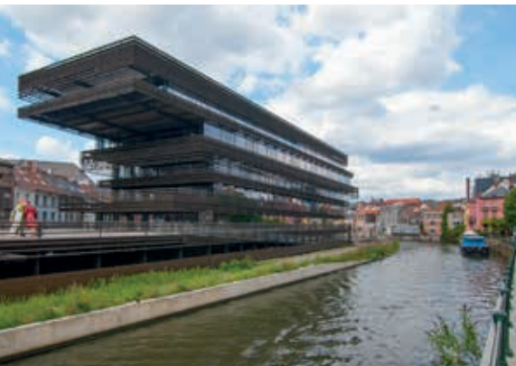
Lauréat catégorie 'International' De Krook à Gand (BE) Architecte : RCR Rafael ARANDA, Carme PIGEM, Ramón VILALTA & Coussée & Goris Architecten foto_photo: © jvdb (InfoSteel)
