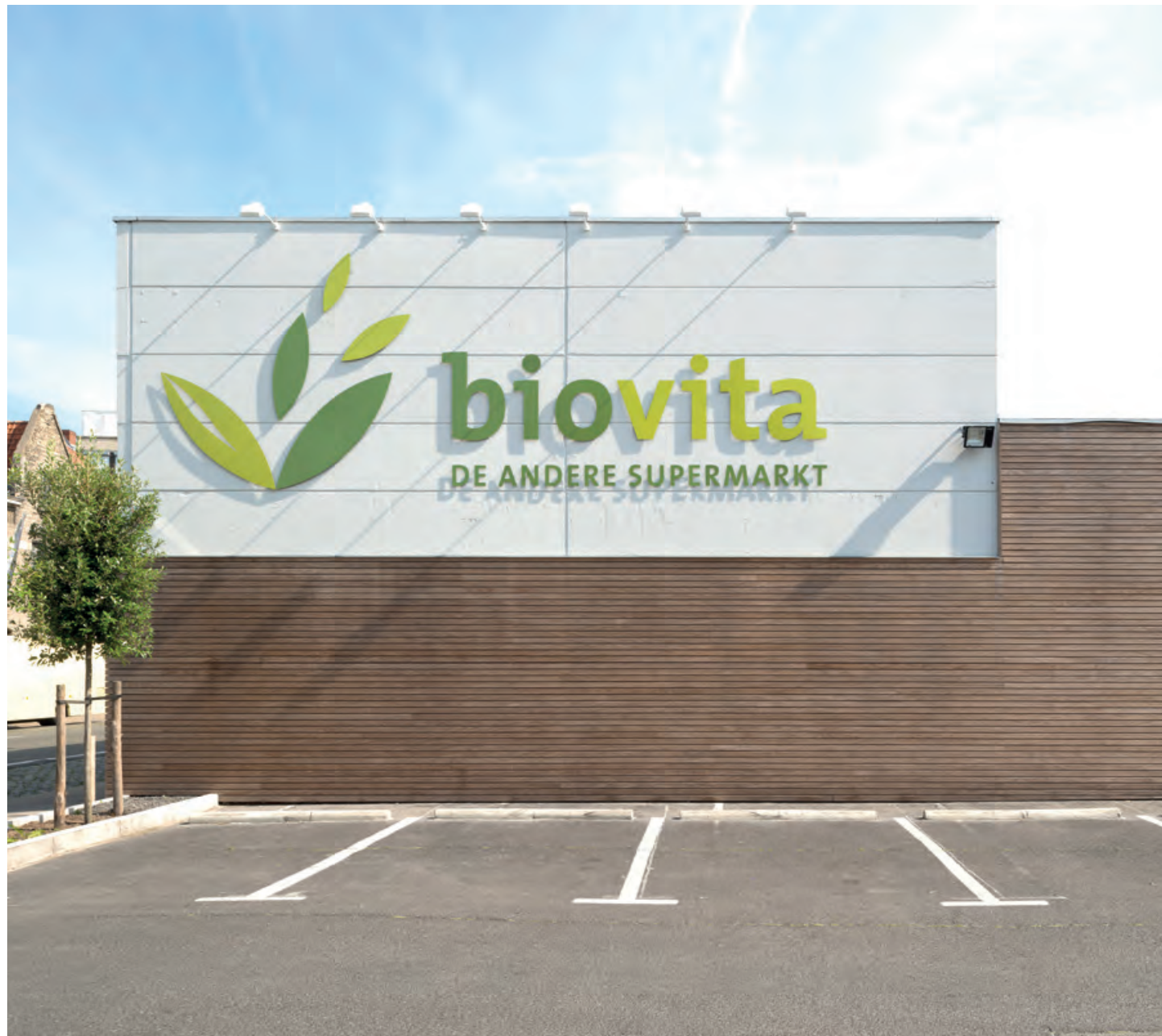
project: Biovita, Roeselare | hout: HOTwood naaldhout | profiel: Clear Pine rhombus | uitvoerder: James Feraine
