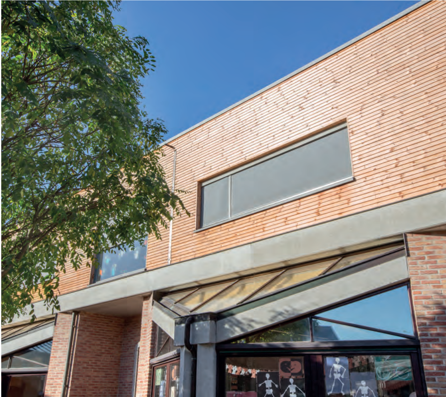
project: School, Eke | hout: HOTwood naaldhout | profiel: Dubbele rhombus | projectontwikkelaar: Casa Domus
