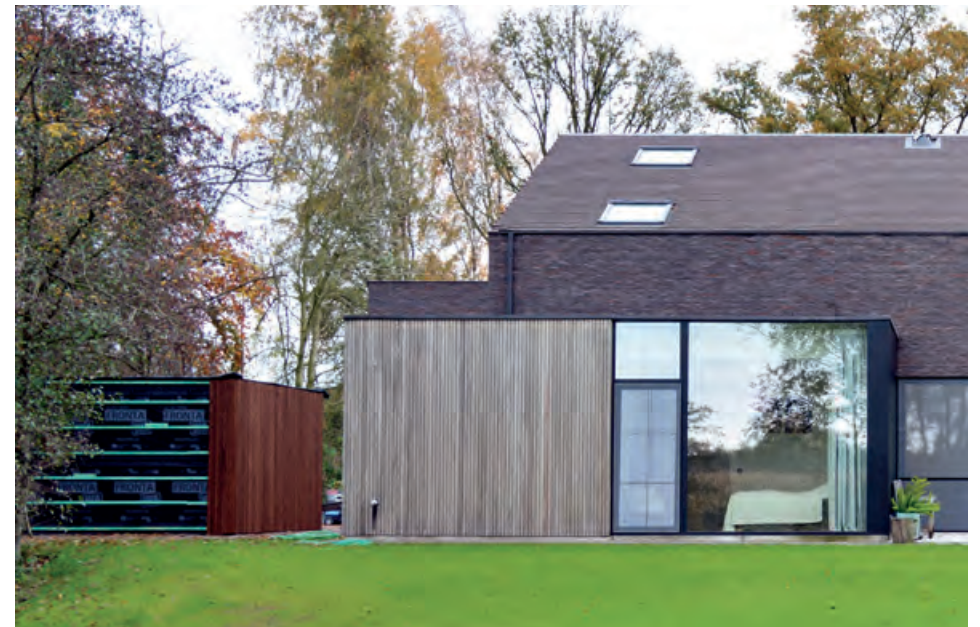
project: Kiekens, Aalter | hout: HOTwood essen | profiel: SV2 | architectenbureau: Architektuurburo Dirk Hulpia bvba | architect: Alejandro Rodríguez | uitvoerder: Baert schrijnwerkerij
