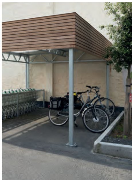
project: Biovita, Roeselare | hout: HOTwood naaldhout | profiel: Clear Pine rhombus | uitvoerder: James Feraine
