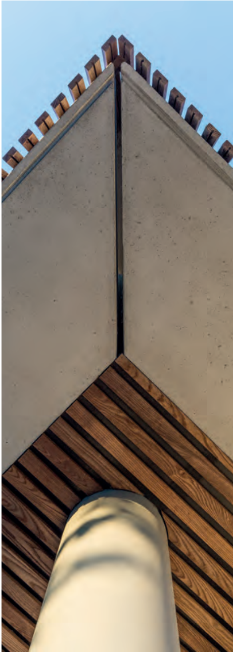
project: Perigio, Nazareth | hout: HOTwood essen | profiel: SV1 20 x 52mm | architect: Schotte-Soetinck Architectenburo bvba | aannemer: Meerschaeghe Gebroeders
