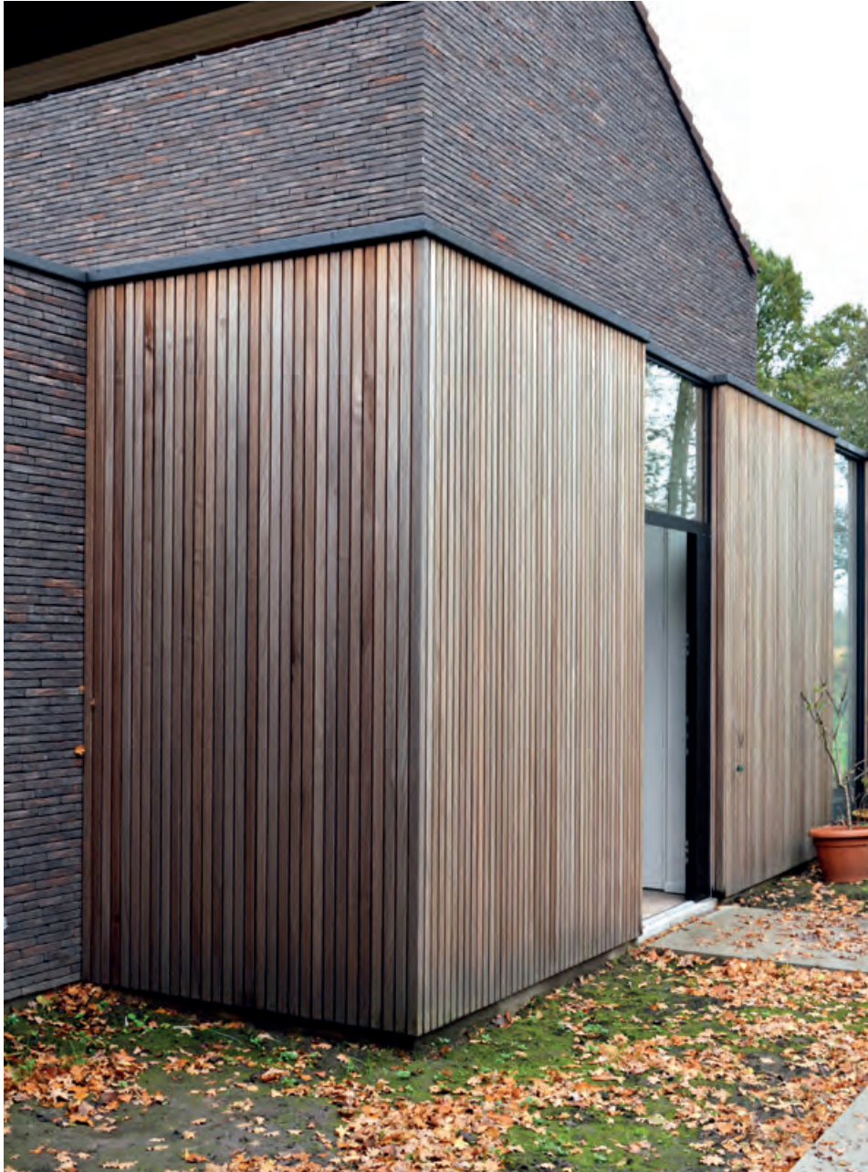
project: Kiekens, Aalter | hout: HOTwood essen | profiel: SV2 | architectenbureau: Architektuurburo Dirk Hulpia bvba | architect: Alejandro Rodríguez | uitvoerder: Baert schrijnwerkerij
