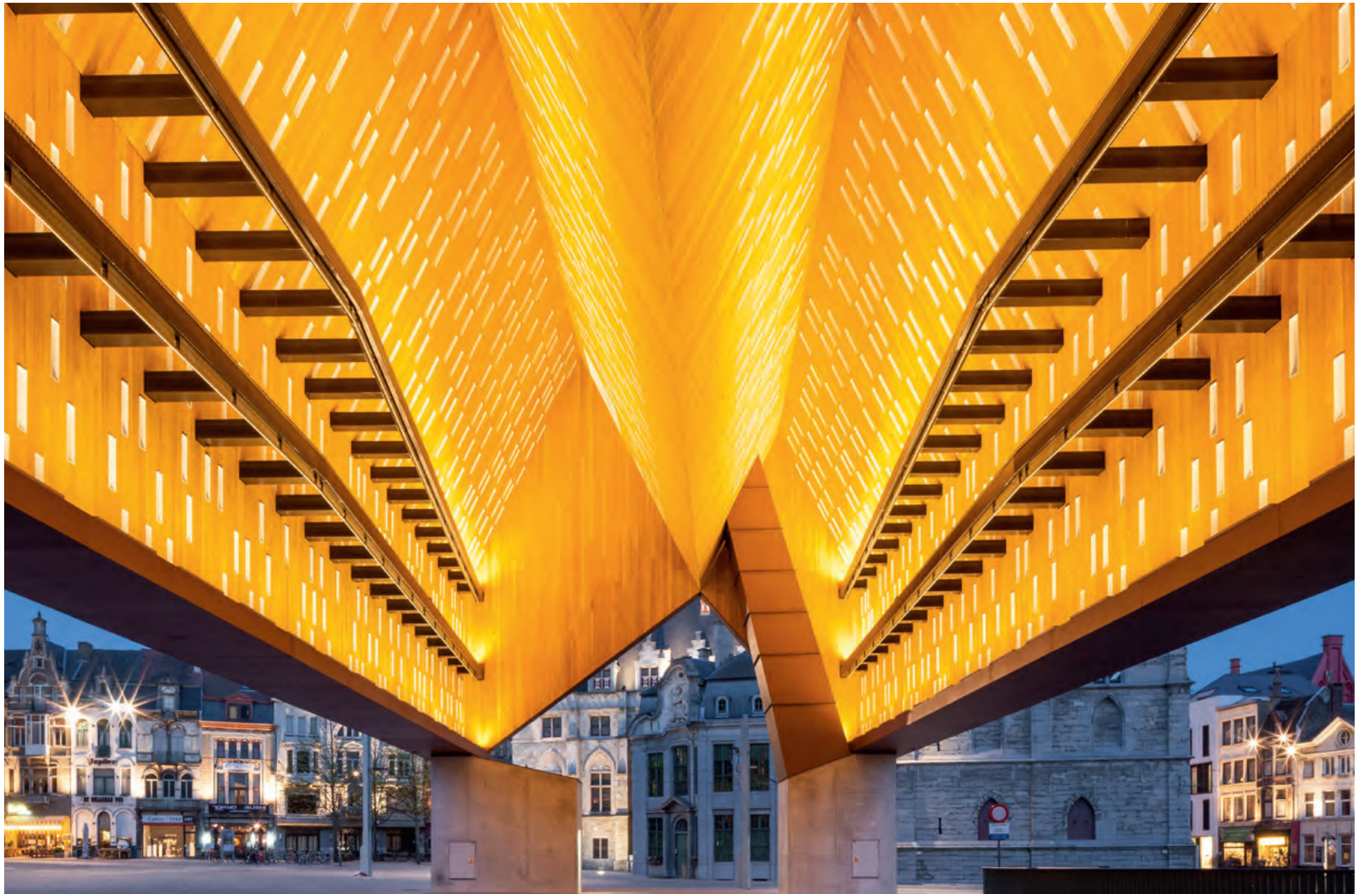
project: Stadshal, Gent | hout: Eik | architect: Robbrecht & Daem | uitvoerder: Besix
