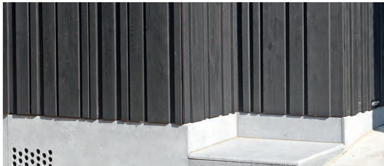
project: Victor Brood & Fijngebak | hout: Burned oak | profiel: Barcode | uitvoerder: Livinlodge voor Frigomil
