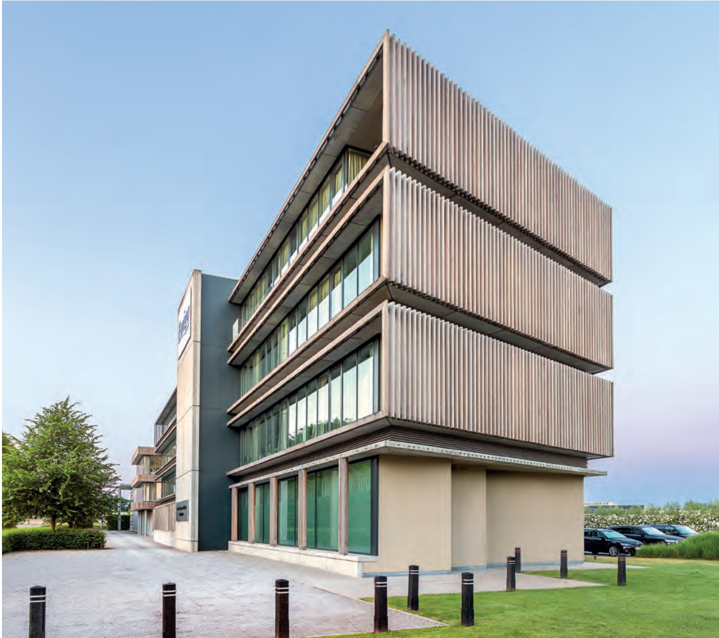
project: Perigio, Nazareth | hout: HOTwood essen | profiel: SV1 20 x 52mm | architect: Schotte-Soetinck Architectenburo bvba | aannemer: Meerschaeghe Gebroeders
