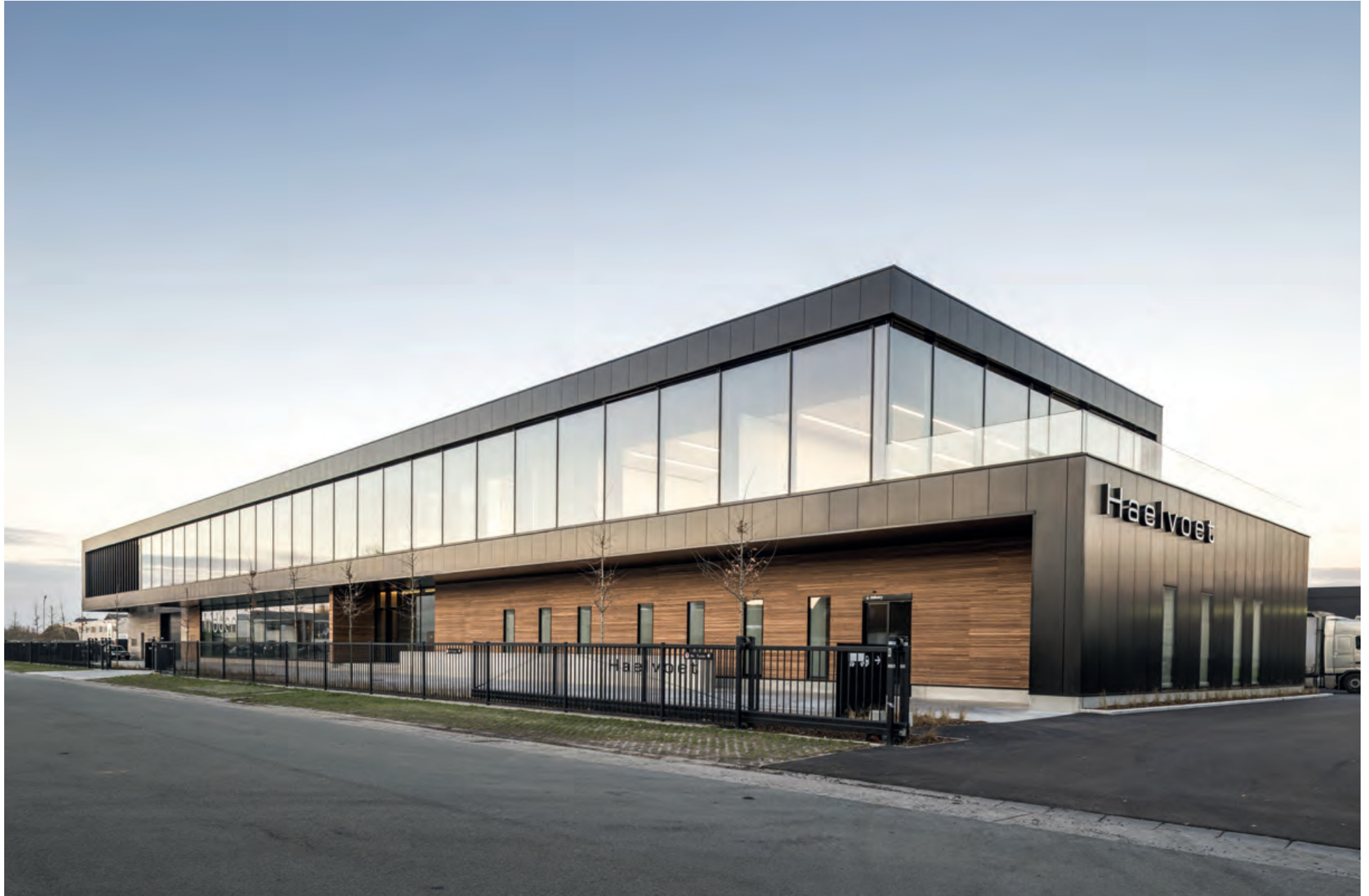
project: Haelvoet, Ingelmunster | hout: HOTwood essen | profiel: Rhombus met QuickClip® | architect: B2Ai
